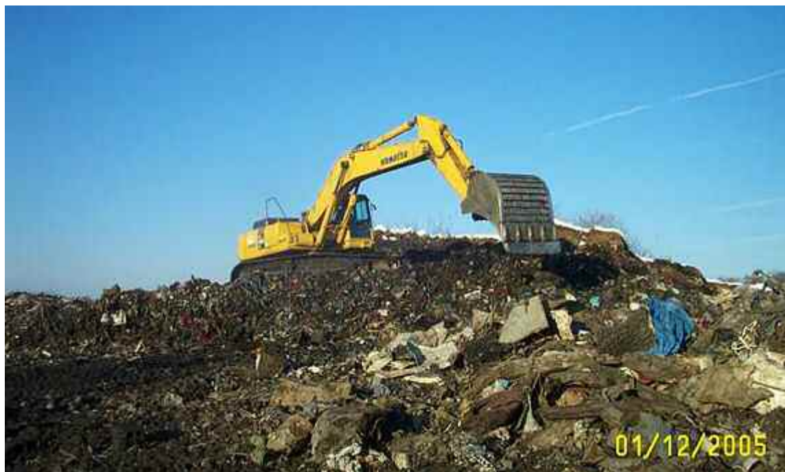
Abbildung 4 Lagenweiser Rückbau einer Abfallschüttung
